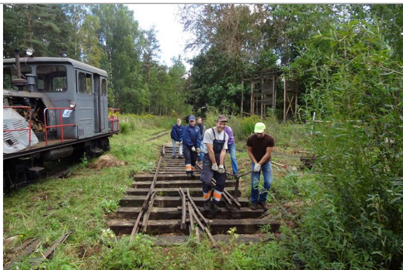
2. attēls. Entuziasti atjauno trūkstošo pārmiju uz trešo un ceturto ceļu (2015. gada oktobris)
